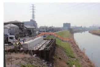
橋脚部分の工事
