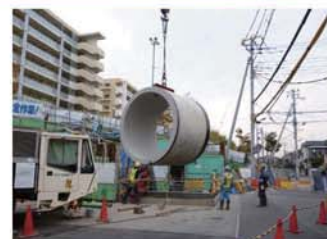
雨水貯留管（管径300cm×延長527m）
