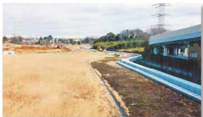
水路の付け替え工事が始まっています
