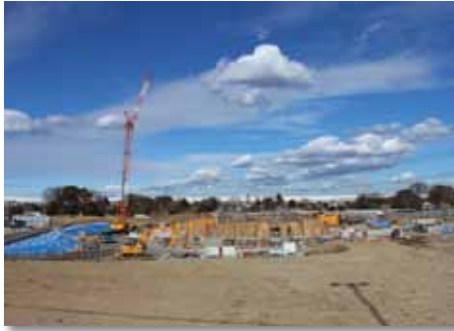
順調に工事が進む火葬施設建設工事
