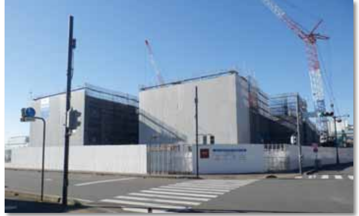
新市立高校建設工事
