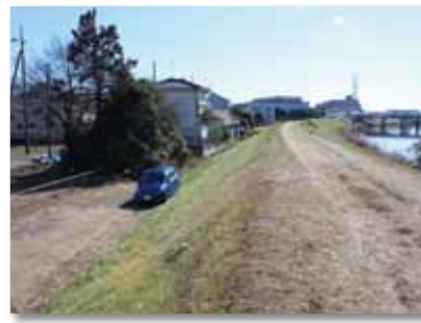
芝川左岸堤脚道路予定地付近
