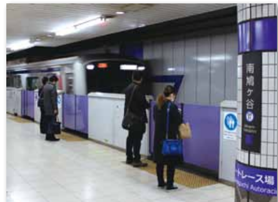
SR南鳩ヶ谷駅のホームドア
