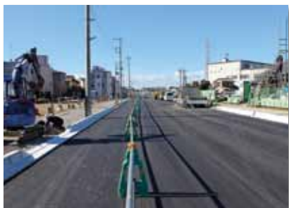
工事が進む里上青木線。里地内から新橋方向を望む
