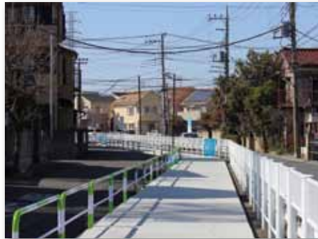
永堀川整備事業・29年度は西公民館通りとの交差点部以西を実施予定
