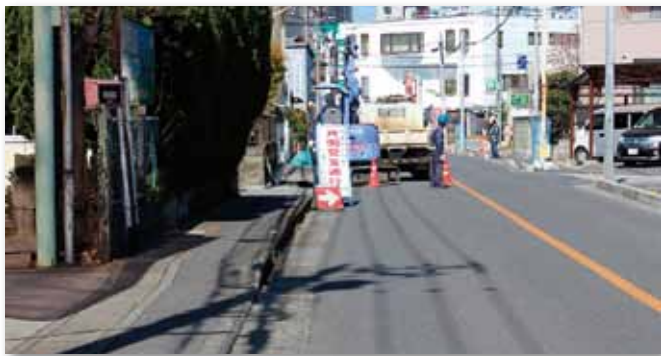
幹線第98号線歩道整備・歩道の起伏を解消
