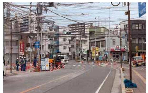
●右折帯の設置工事
