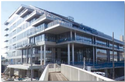
●完成間近の新庁舎1期棟
