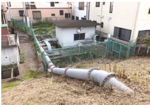
●改修される永堀川のポンプ場
