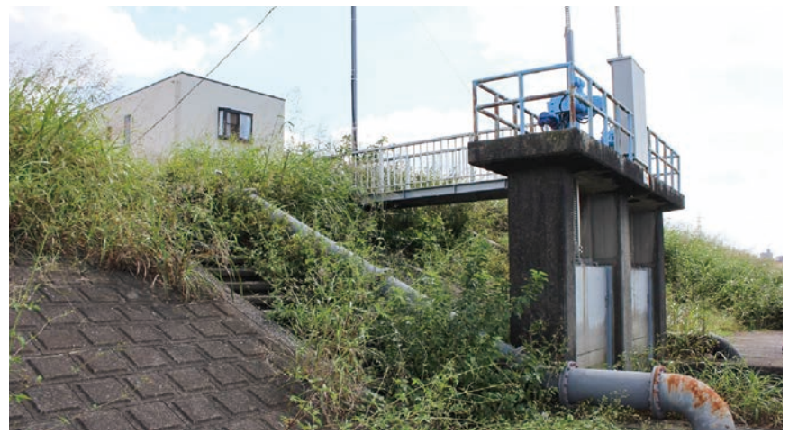
●里ポンプ場（小屋）から新芝川への排水管と水門
