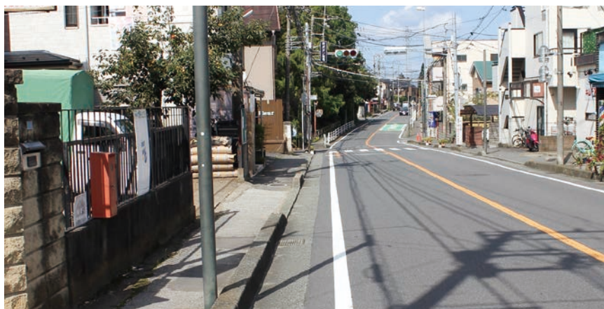
●桜町小学校付近の歩道の状況
