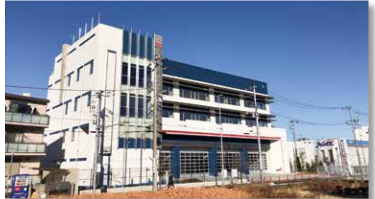
●東消防署全景
